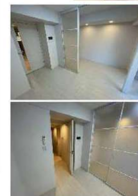
引き戸設置写真
