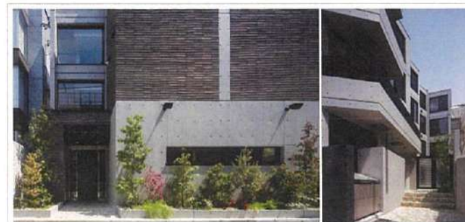
401号室 原状回復工事予定
