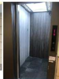
エレベーター
