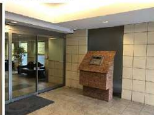
エントランスオートロック
