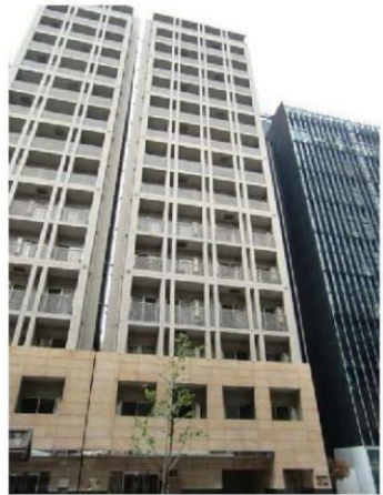
外観タイル貼り
