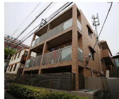
外観タイル貼り
