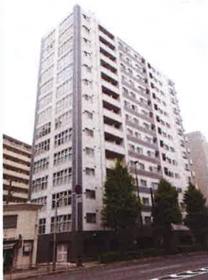
室内・設備・周辺写真
